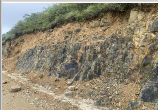
生态修复前的护坡
